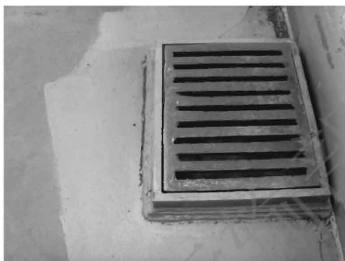
图 14-1 应避免的泄水口设置
