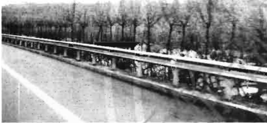
图7-2 填方路基边坡一级平台栽植乔木绿化效果
