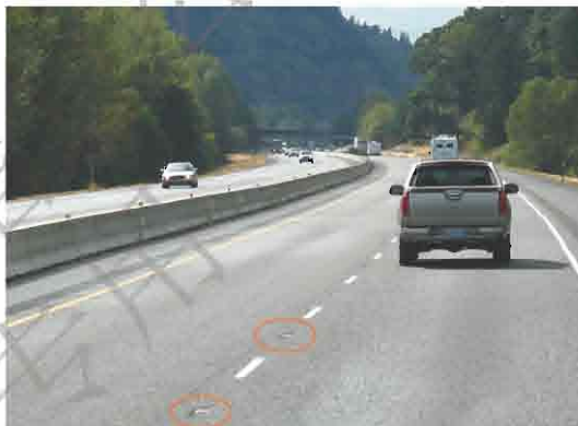
图 10-21 槽式安装的突起路标
