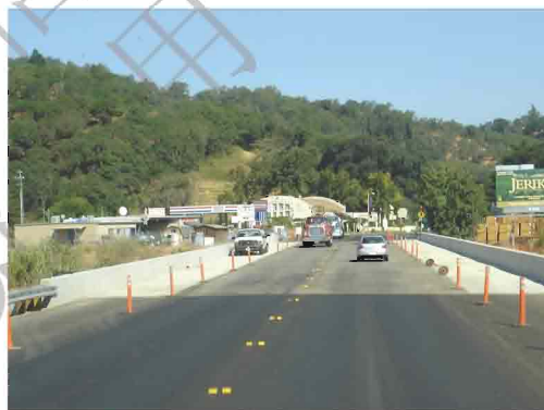
图 2-2 临时交通标线的设置
