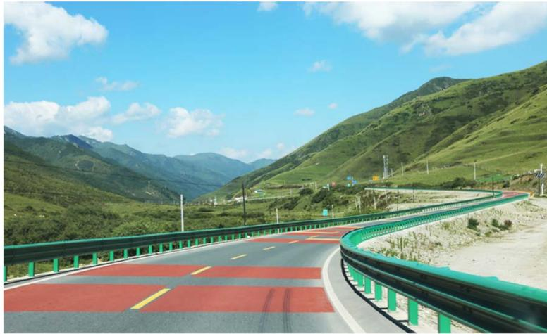
急弯路段间隔设置彩色防滑标线和横向振动标线
