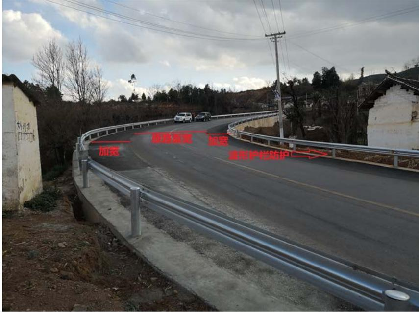
陡坡急弯两侧拼宽并铺筑 SMA 抗滑面层
