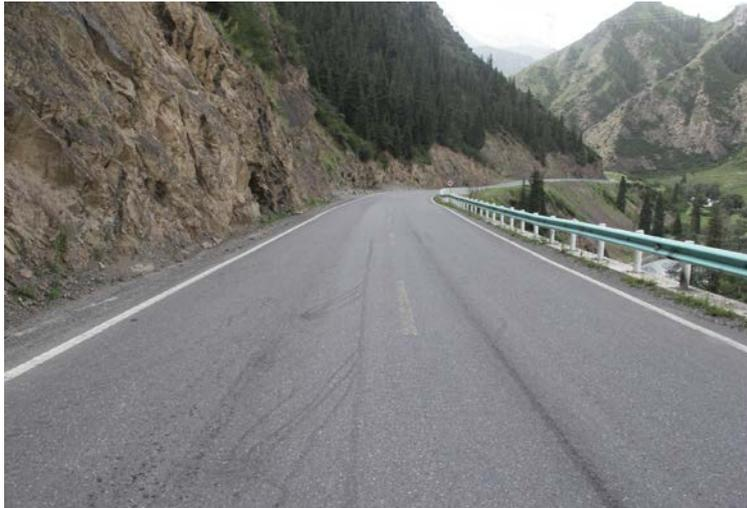
完善路侧防护设施，于涵洞两侧增设二（B）级波形梁护栏，合适位置采用外展型波形梁护栏。同时，采用混凝土修复，利用原有护坡基础；于路基沉陷段新建下挡墙防护以及扶壁式挡墙，用于抵御自然灾害。
