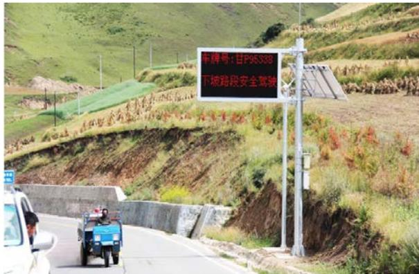
长下坡路段设置交互式热成像货车制动预警系统
