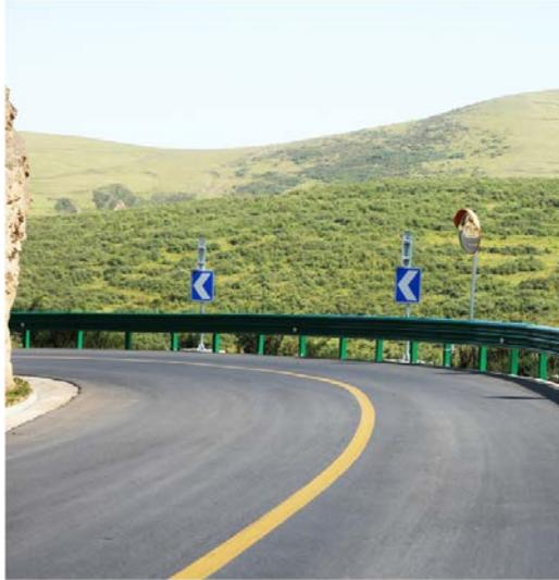
弯道路段设置 SB 级波形梁护栏
