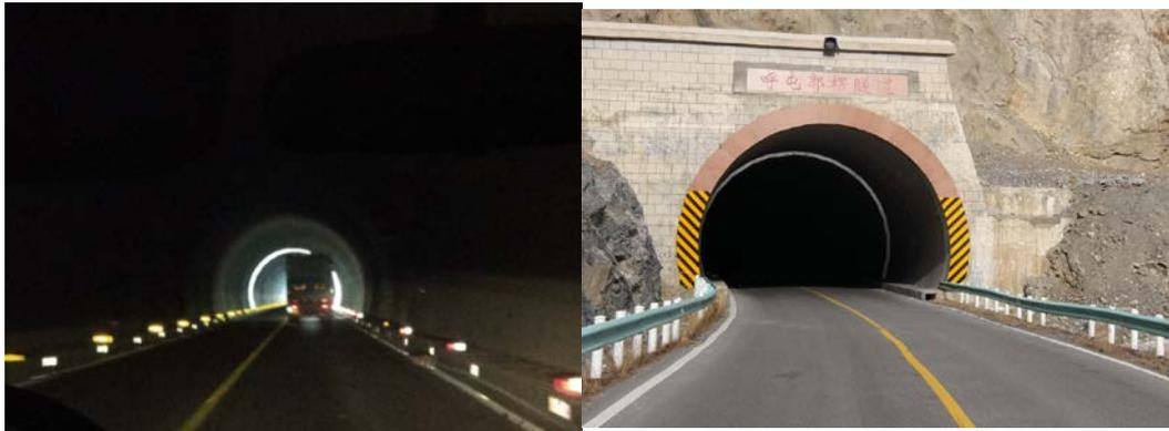
完善沿线标线，重新施划行车道边缘线、减速震动标线以及行车道中心标线。
