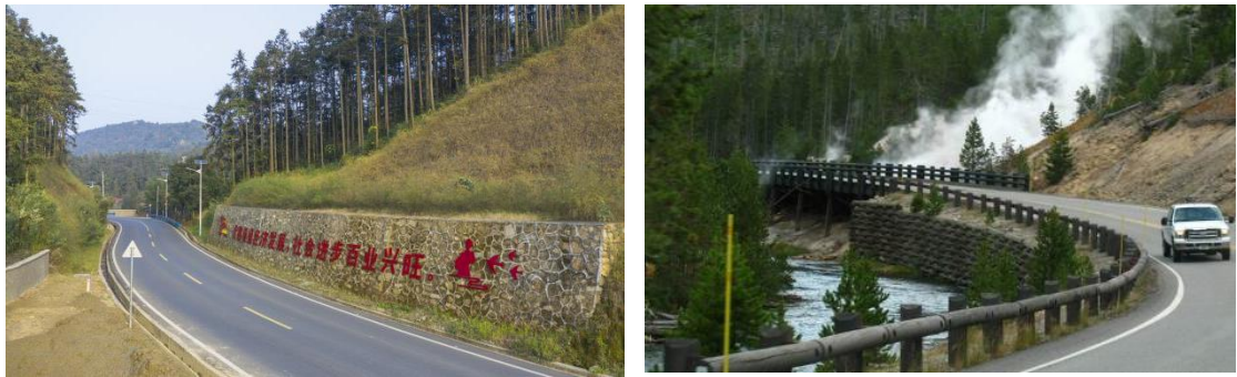
图 3-18 路堤挡墙实例
