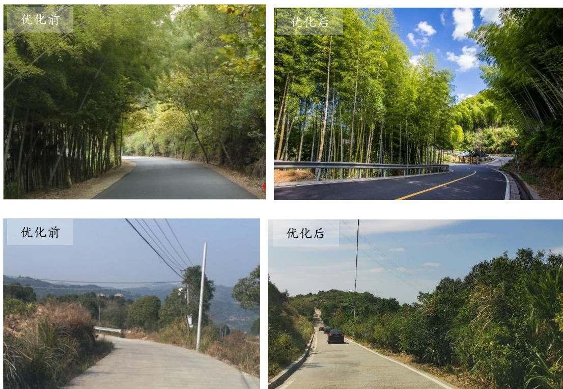
图 4-5 运用反光警示标标记轮廓提高转弯路段安全性
