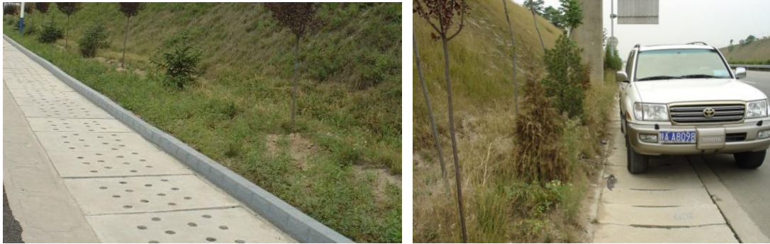
图 3-27 矩形圬工盖板边沟的应用
