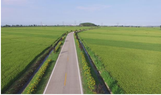
图 5-24 采用排水沟实现路田分家
