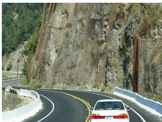
图 3-21 主动防护网防护
