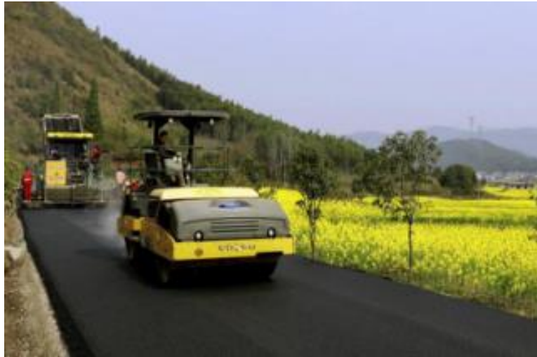
图 3-13 高标准建设施工
