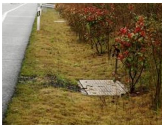
图 3-26 暗埋式生态边沟的应用
