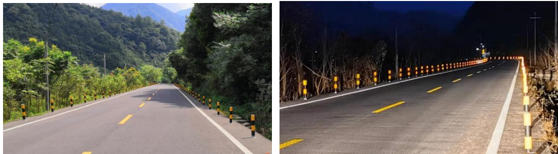
图 4-5 运用反光警示标标记轮廓提高转弯路段安全性
