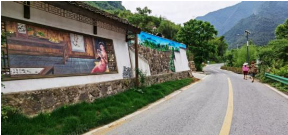
图 1-7 房屋外墙立面改造
