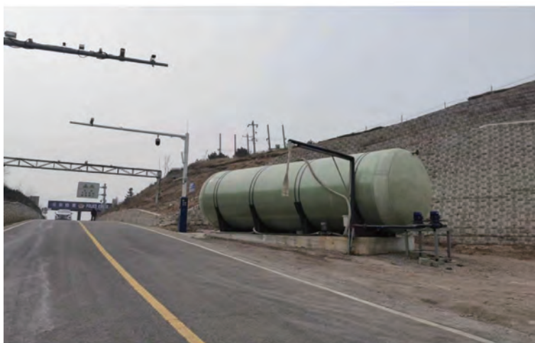
图 23 京冀交界处环保无氯融雪剂储备罐
