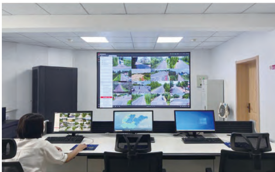
图1 齐河县农村公路信息化大厅
