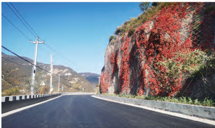
图 22 边坡防护工程中保护沿线乔灌木
