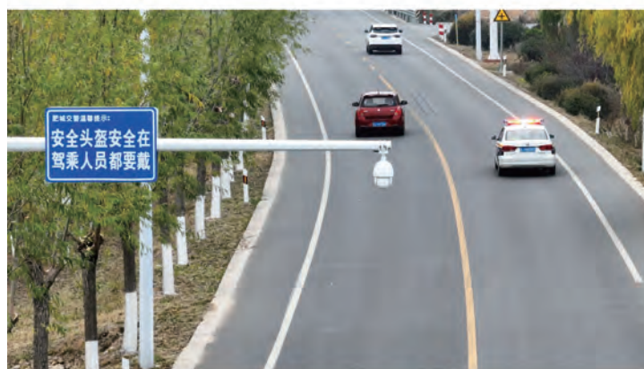
图5 道路监控系统
