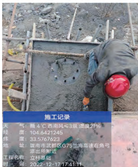
图4 工程施工记录
