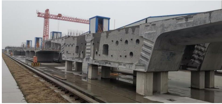
图 7-3 检修台座示意图
