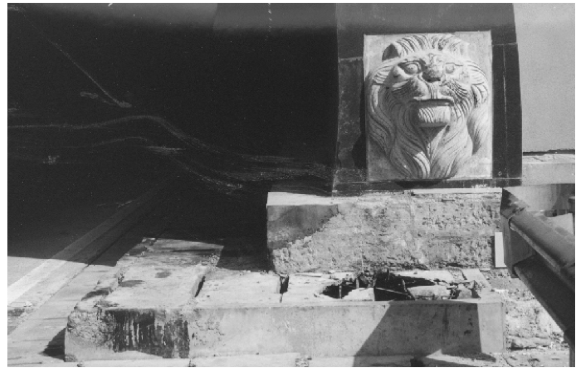
图 5-2 端墙式隧道洞口交通事故示例
