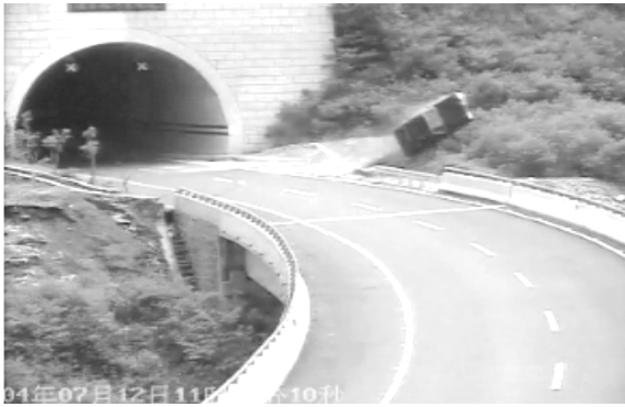
图 5-2 端墙式隧道洞口交通事故示例
