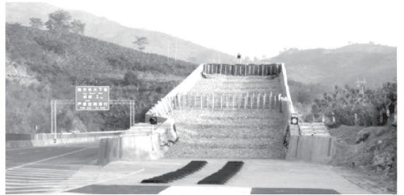
图 11.3.8 网索式避险车道平面结构示意图
