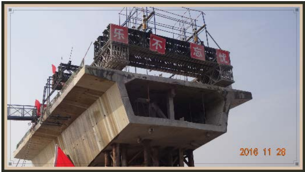
老桥拆除施工
