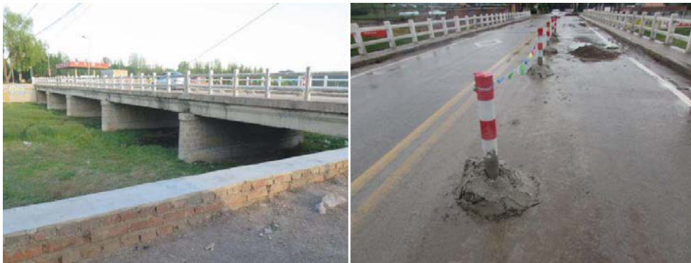
凌兴线六官营子中桥原桥
