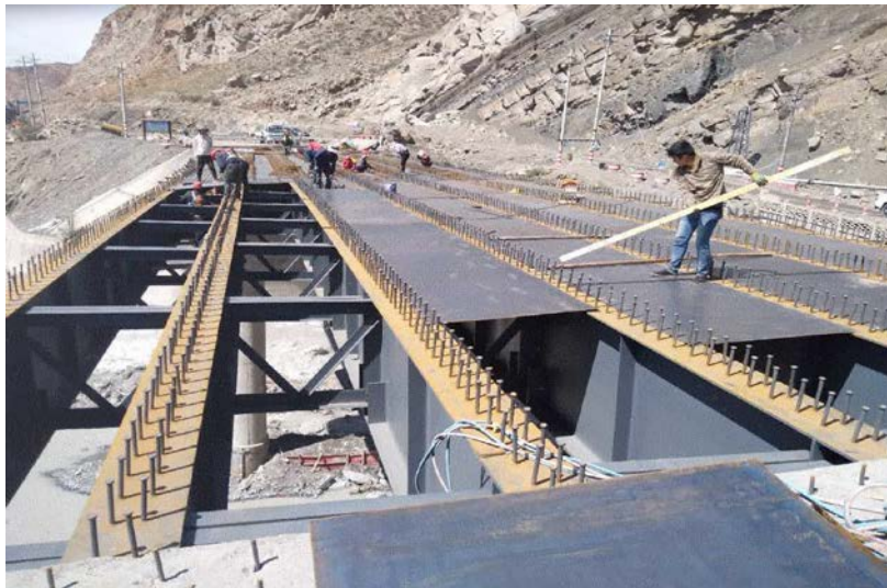
钢梁间钢板底模
