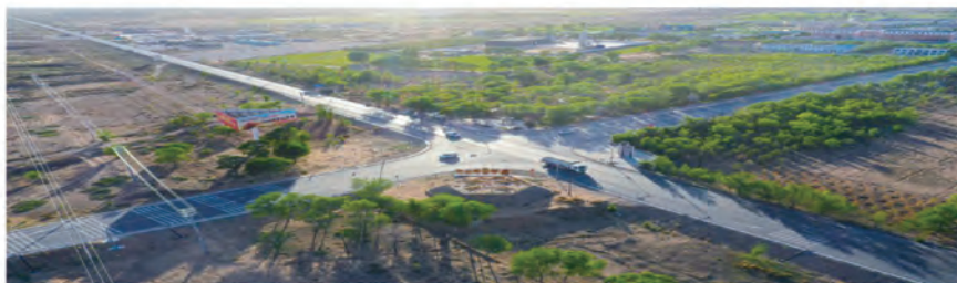
图 1 鄂托克前旗农村公路俯瞰
