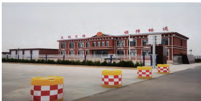
图7 昂素农村公路养护站
