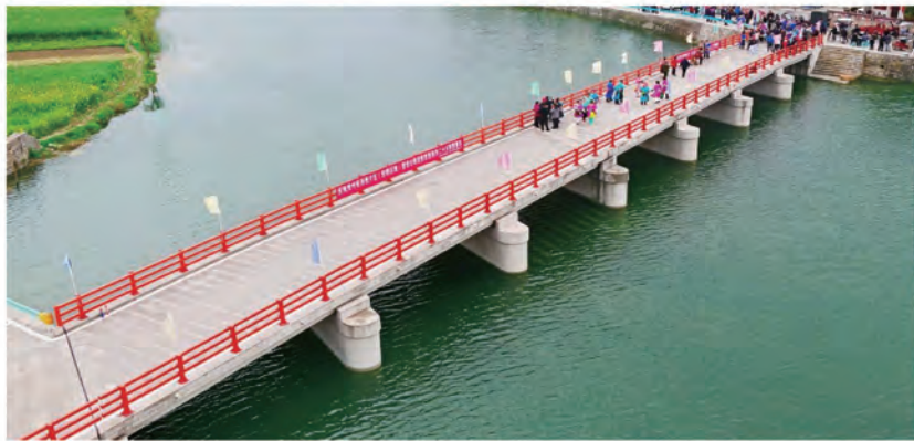
图4 西秀区九溪桥危桥改造项目
