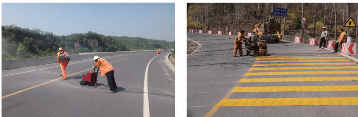
图5 县乡公路日常养护
