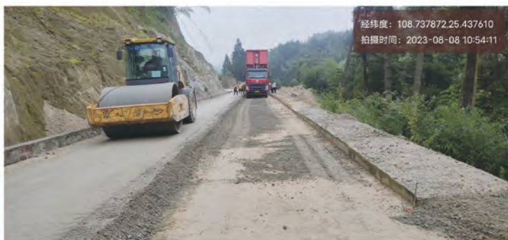
图2 施工监理人员通过“工程巡检”App上传的融水县乡联网施工现场照片
