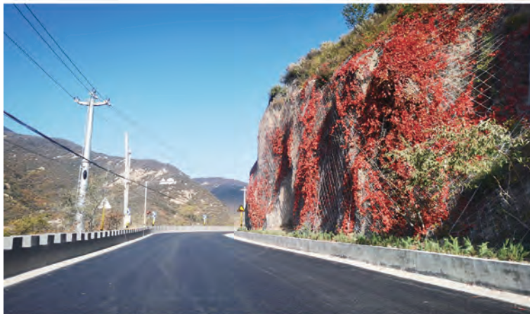
图 22 边坡防护工程中保护沿线乔灌木
