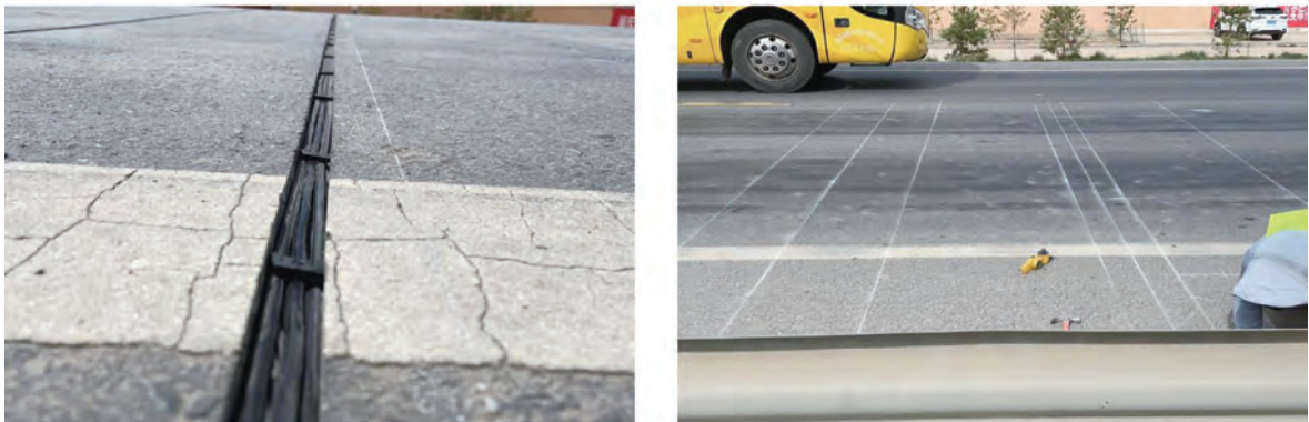
图 12 动态称重设备安装
