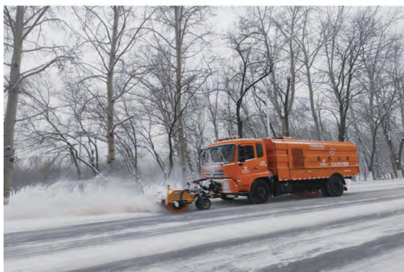
图 19 松闫路除雪作业
