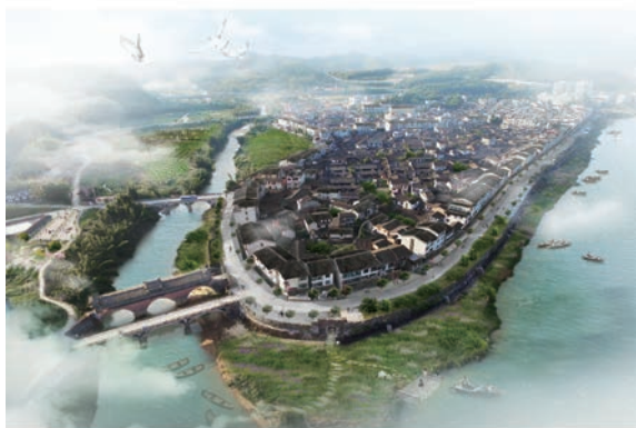
图2 贡川项目环古镇公路
