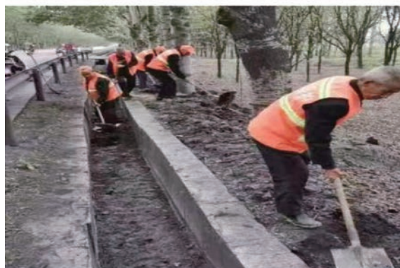
图 2 养护人员清除排水渠
