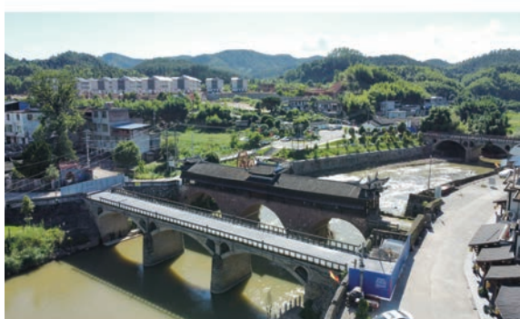
图4 贡川项目桥梁改造
