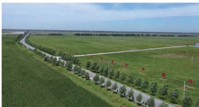
图 11 建成的黄河滩区居民迁建道路
