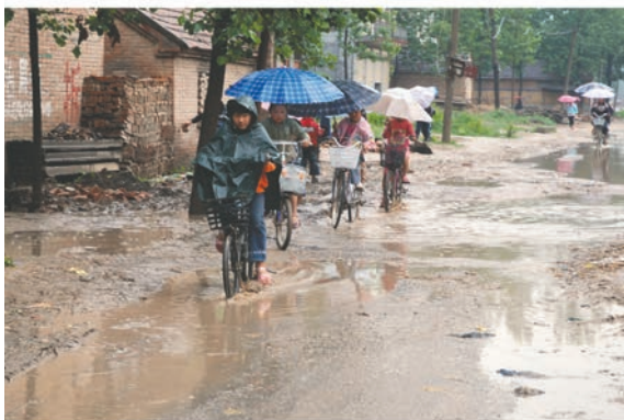
图9 曹县大集镇道路改造前
