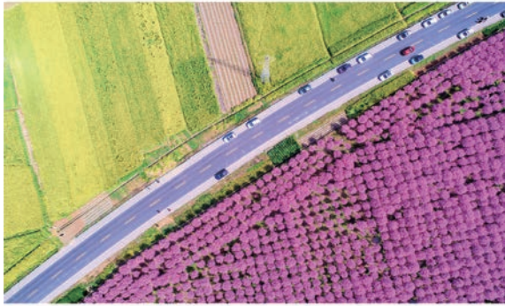
图2 十天高速公路勉县引道
