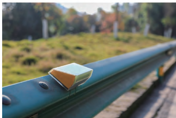
图8 太阳能自发光护栏诱导标
