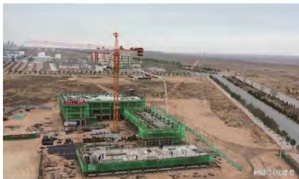
图 11 润阳悦达多晶硅项目施工现场
