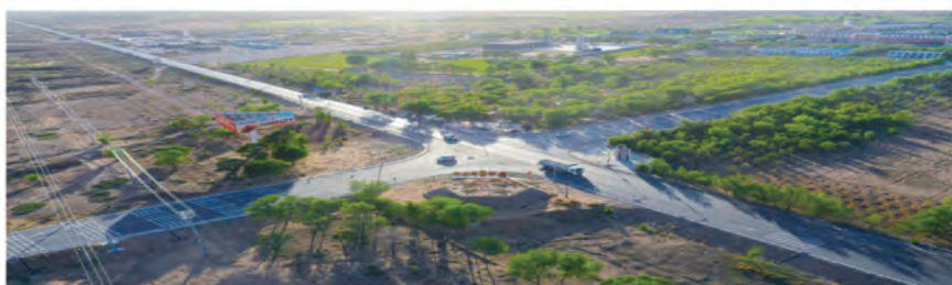
图 1 鄂托克前旗农村公路俯瞰
