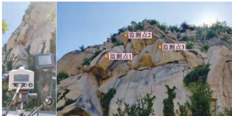
图 12 边坡预警系统和岩体监测
