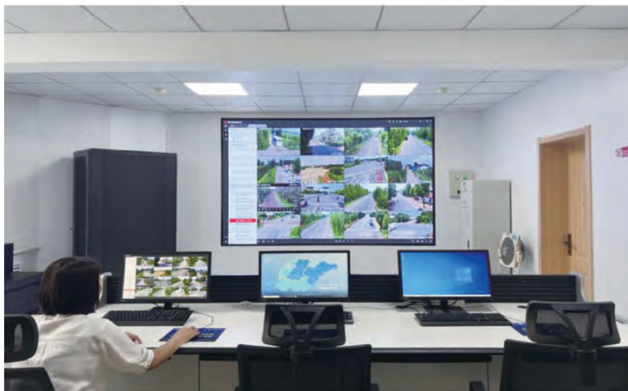
图1 齐河县农村公路信息化大厅
