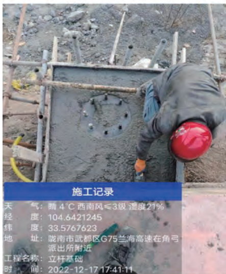
图4 工程施工记录
