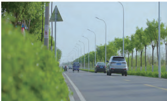
图4 小站中心道现场实景图
