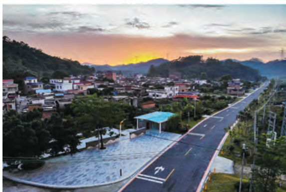
图8 佛山市高明区杨和镇皂幕山通景公路Y651井皂线
