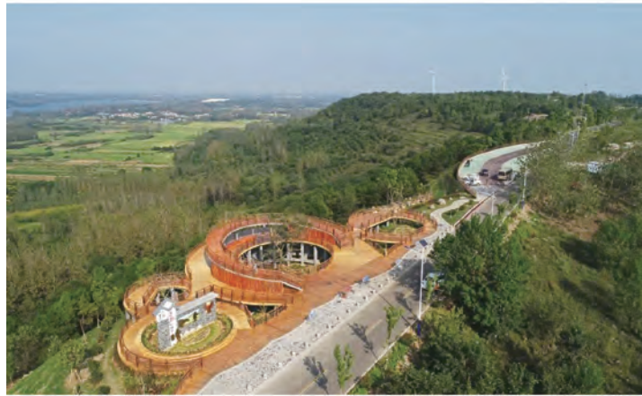
图 15 来安红岭段·半塔岭上观景台
