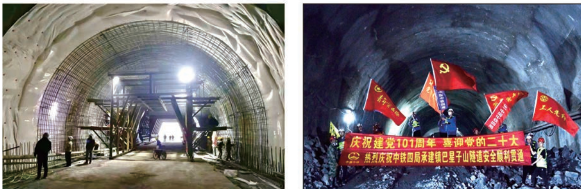
图8 镇巴县星子山隧道及引线工程
