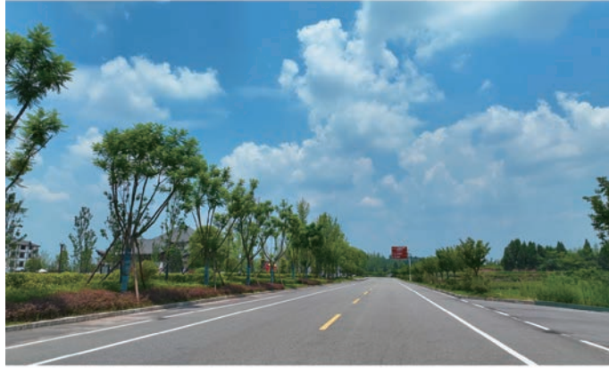
图6 新改建农村公路——县道楠木至八尔湖公路图片
