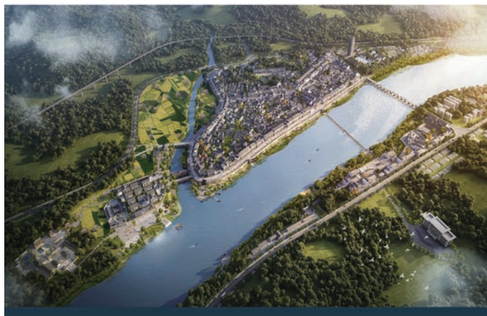
图 15 沙溪河贡川段水上综合项目
