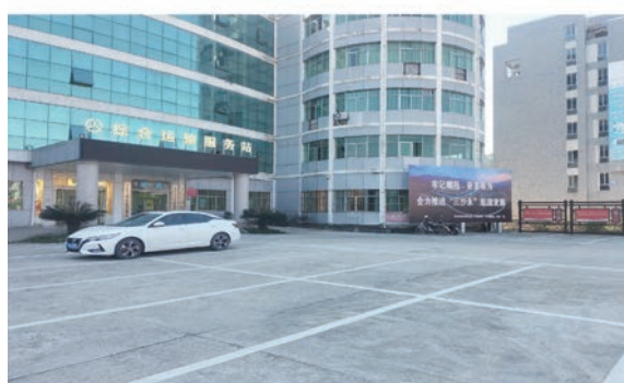
图5 贡川项目综合运输服务站
