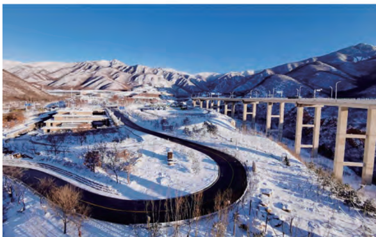
图 24 铲冰除雪作业后的路况
