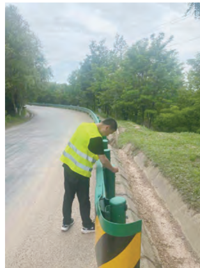
图9 安装智能传感设备
