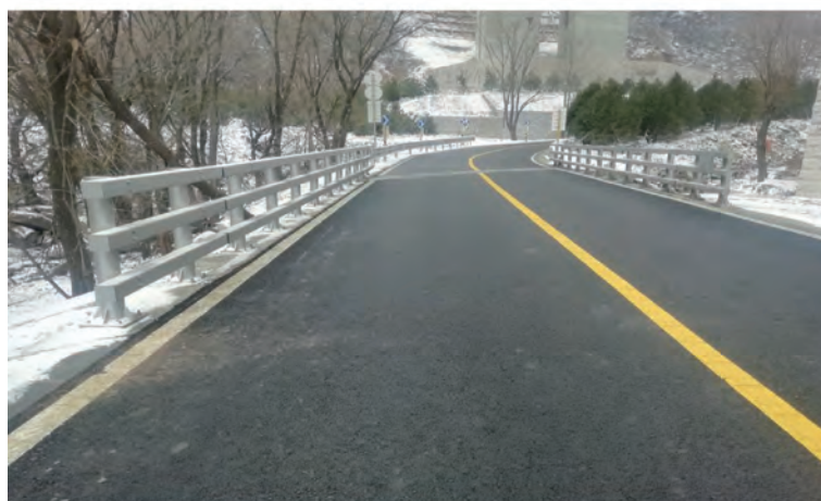
图 21 松闫路安防工程完工后
