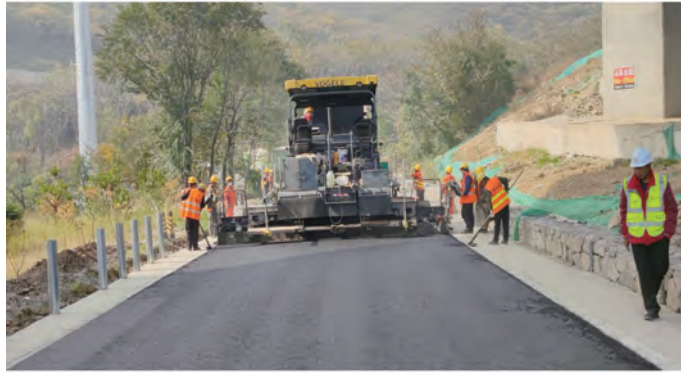
图 11 铺设 DTC 相变融冰雪材料
