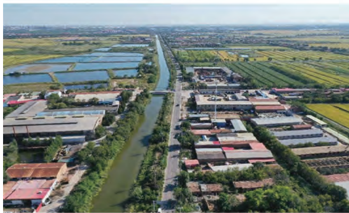
图 1 双顺路维修后航拍全景
