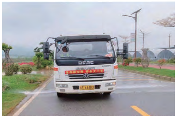
图4 高明区农村公路道路洒水作业
