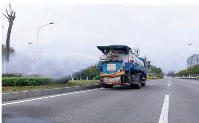
图6 道路养护作业
