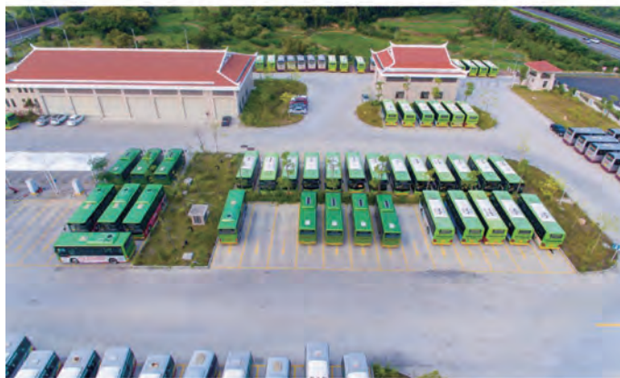
图 7 惠安综合交通枢纽站
