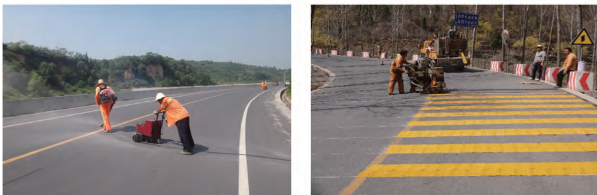
图5 县乡公路日常养护
