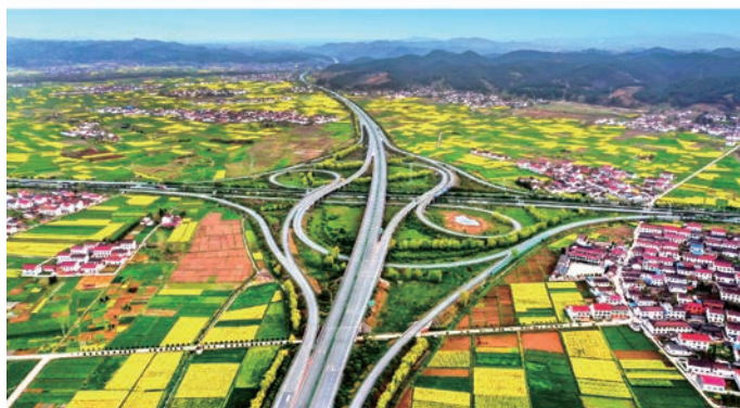
图1 城固县上元观镇西汉、十天高速公路立交
