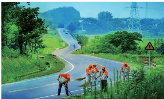
图3 管养人员进行日常养护
