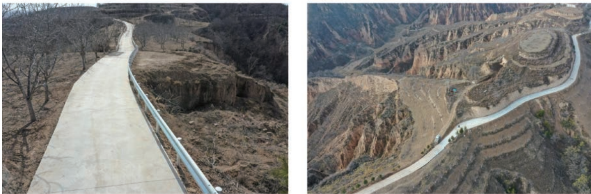
图1 “上级补助+乡镇自筹”建设——自然村通硬化路
