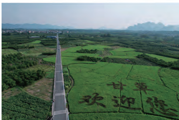
图 14 灵川县潭下至九屋公路
