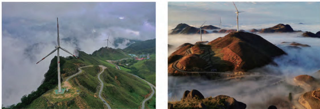
图8 龙胜南山生态旅游公路最新现场图（一阶段施工已完成）
