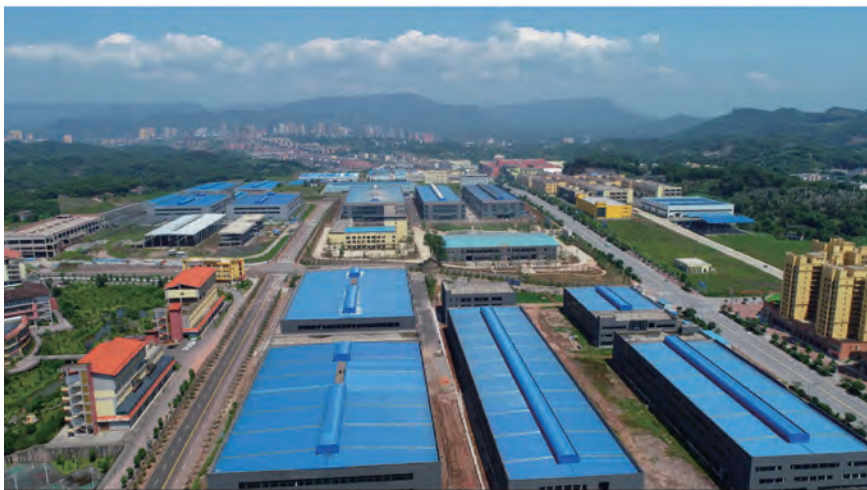
图 11 赤水市竹业循环经济工业园区
