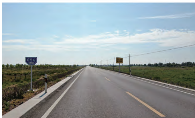
图3 鄂托克前旗农村公路 X611 城川至三段地标准化二级公路
