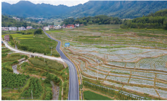
图8 汝城县南洞乡中药材产业路
