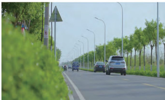
图4 小站中心道现场实景图
