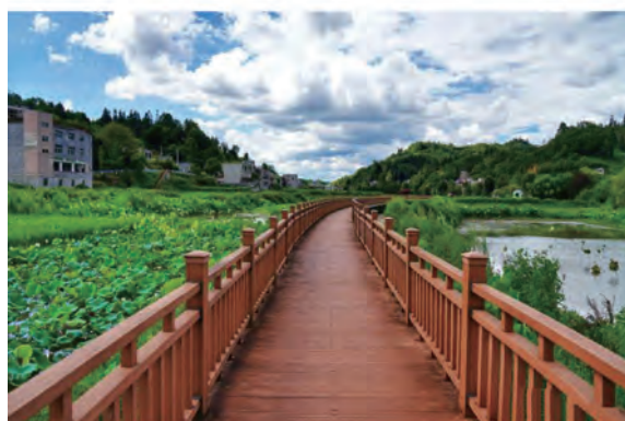
图 13 西秀区 X421 关帝庙至旧州公路下 九溪荷花栈道
