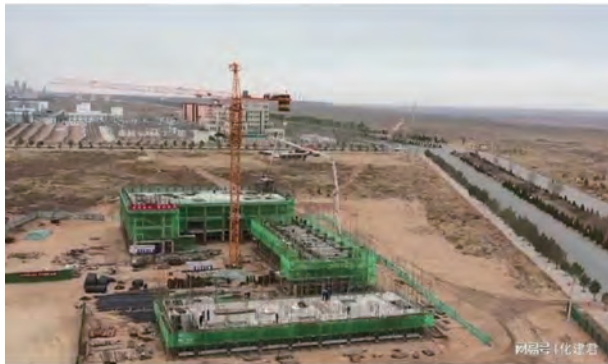
图 11 润阳悦达多晶硅项目施工现场
