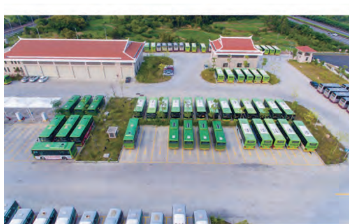
图 7 惠安综合交通枢纽站
