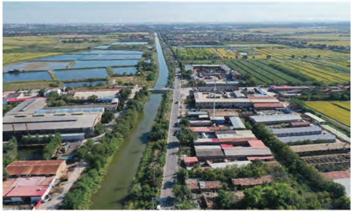
图 1 双顺路维修后航拍全景
