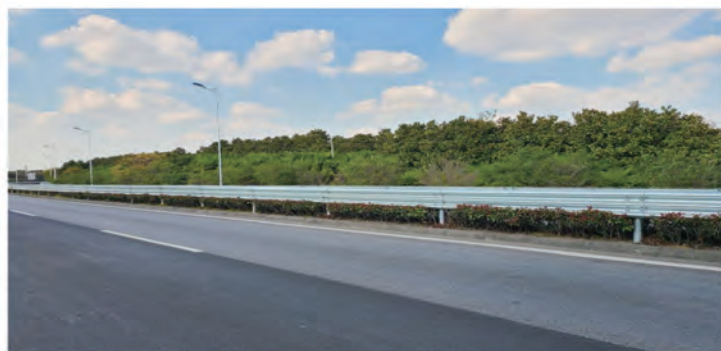
图 13 提升安防建设
