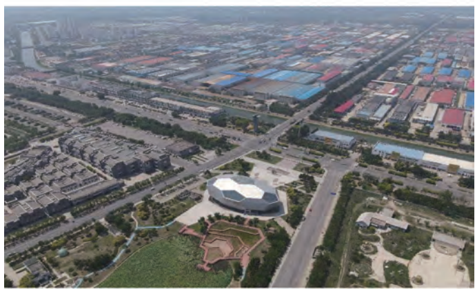
图6 工业园区航拍
