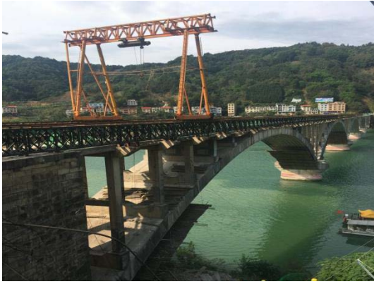
图 1 改造施工中的红水河大桥
