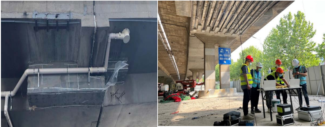
图 2 牛腿局部支撑及体外预应力伴随监测技术
