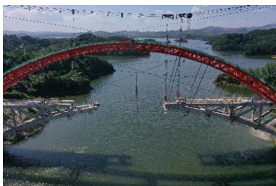
图3 逐段切割旧桥
