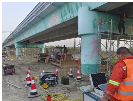
图 2 整联千斤顶布设
