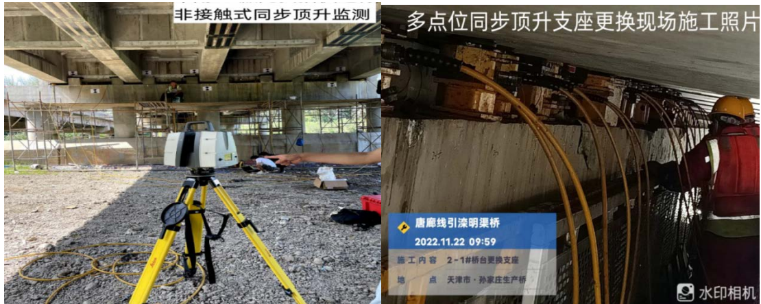
图 1 多点位同步顶升和非接触式同步监测
