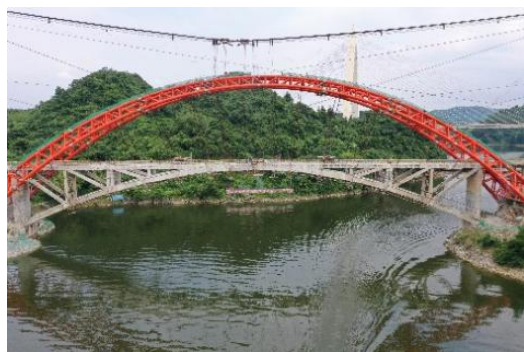
图2 安装体系转换装置
