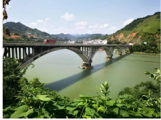
图 2 改造后的东兰红水河大桥
