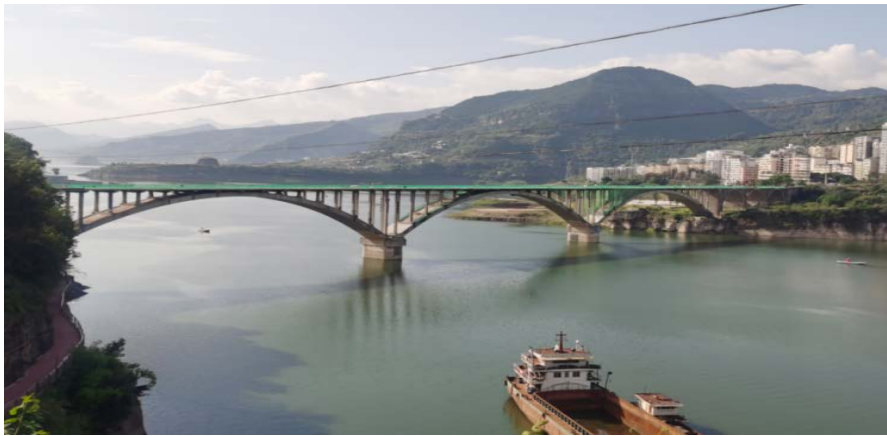
图 1 云阳双江大桥全景图
