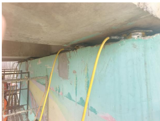
图 1 墩顶千斤顶布设
