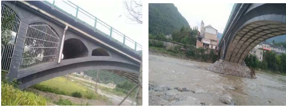
图 1 桥梁加固后实拍图
