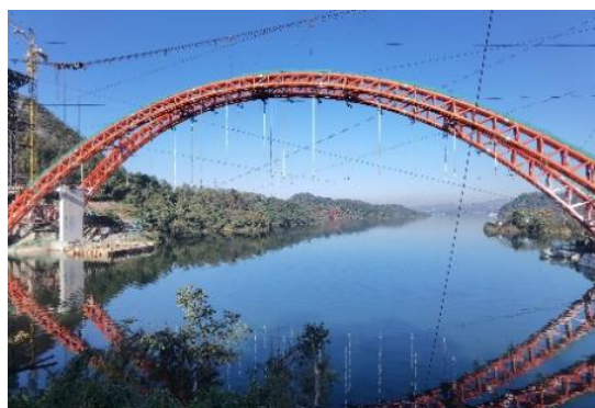
图4 旧桥拆除完成
