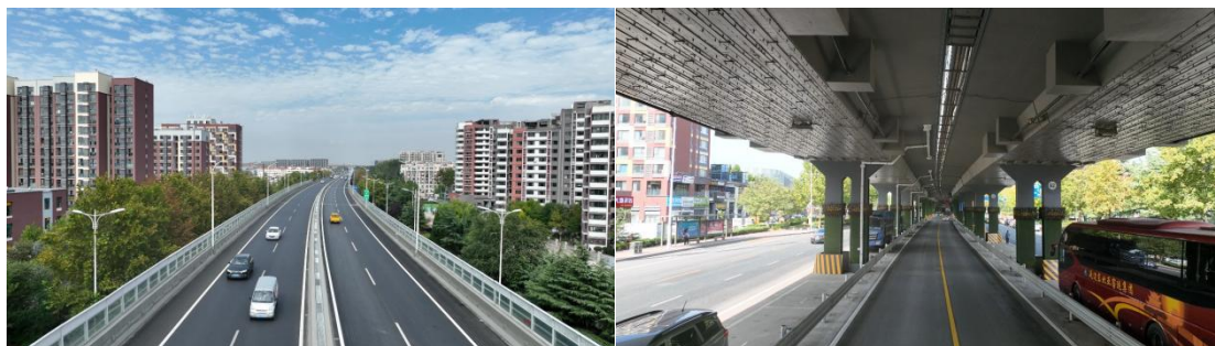
图 1 加固通车后的 G20 西流高架桥
