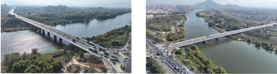
图 1 南凌大桥全景图
