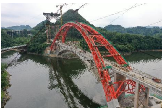
图1 旧桥扣挂于新桥拱肋上
