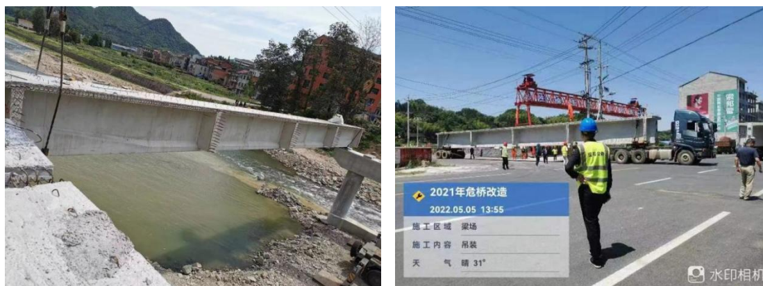
图2 T梁运输及吊装
