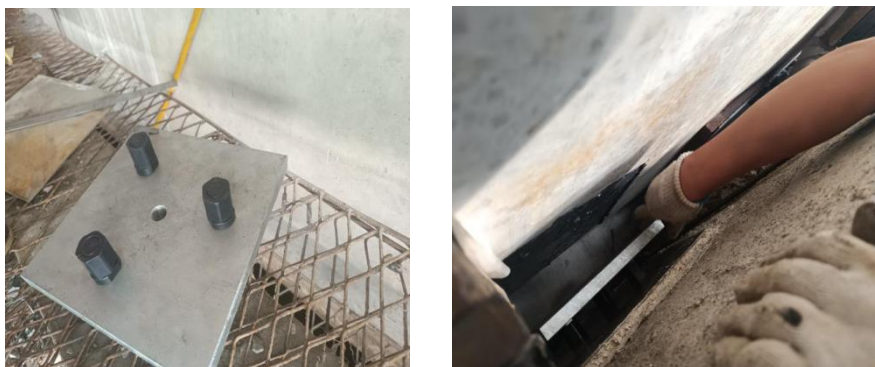
图 1 支座反压装置安装图
