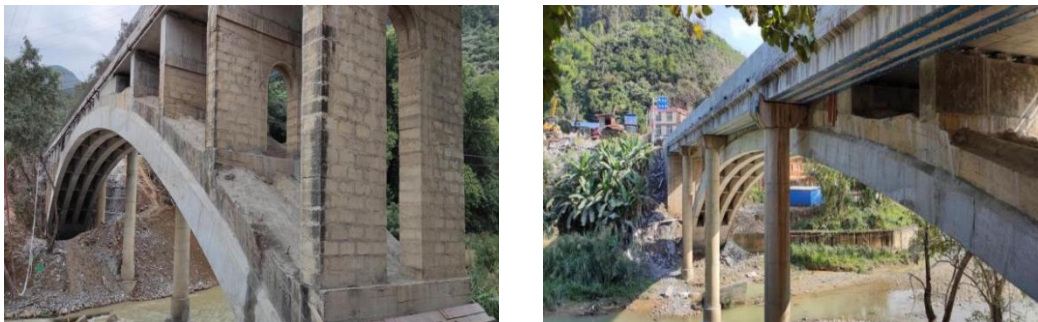
图 1 加固完成后照片
