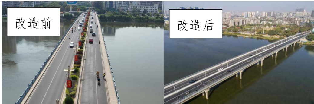
图 1 改造前后桥梁全景图
