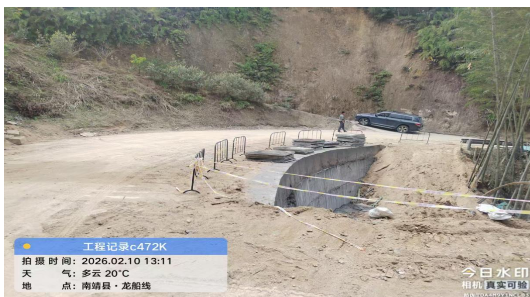
图 5 2025 年南靖县农村公路 17 处灾毁修复工程 X574 船龙线 K2+600
