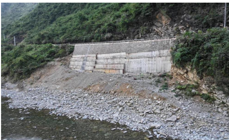
图 3 Y059 城北线 K0+800 路基修复后
