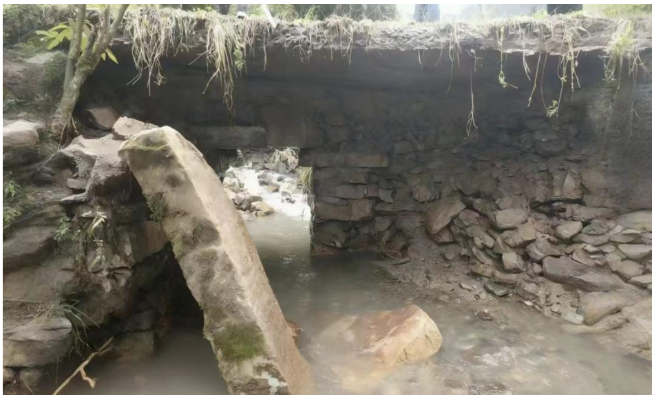
图 1 C905 聂二线涵洞施工前
