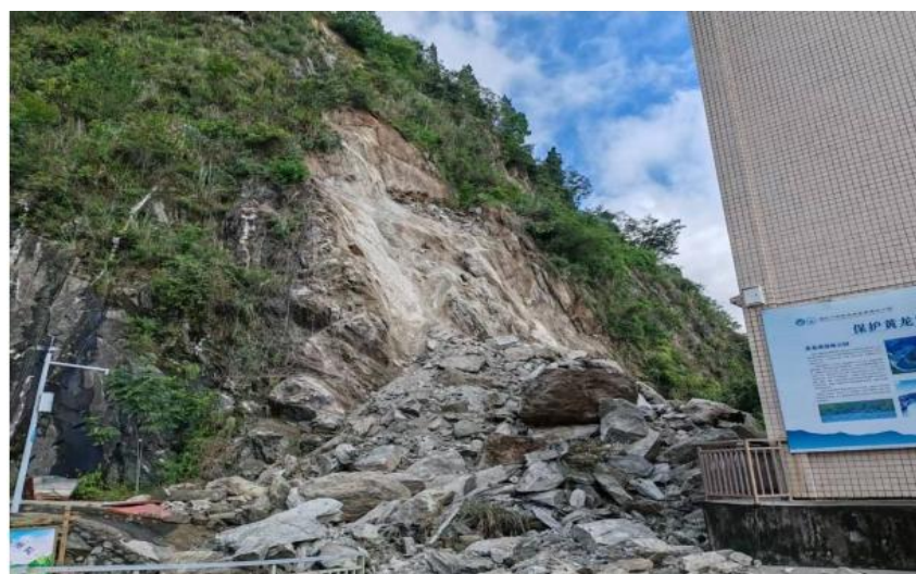
图1 黄龙滩水库码头山体滑坡灾情全貌
