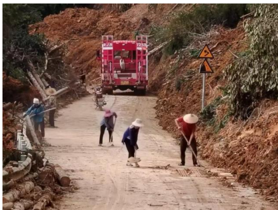
图 15 打通抢险设备进入灾区通道
