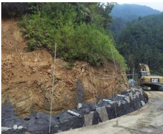
图 13 对不稳定山体增设上挡墙预防塌方风险 图 14 开展路面裂缝处置防范病害扩大
