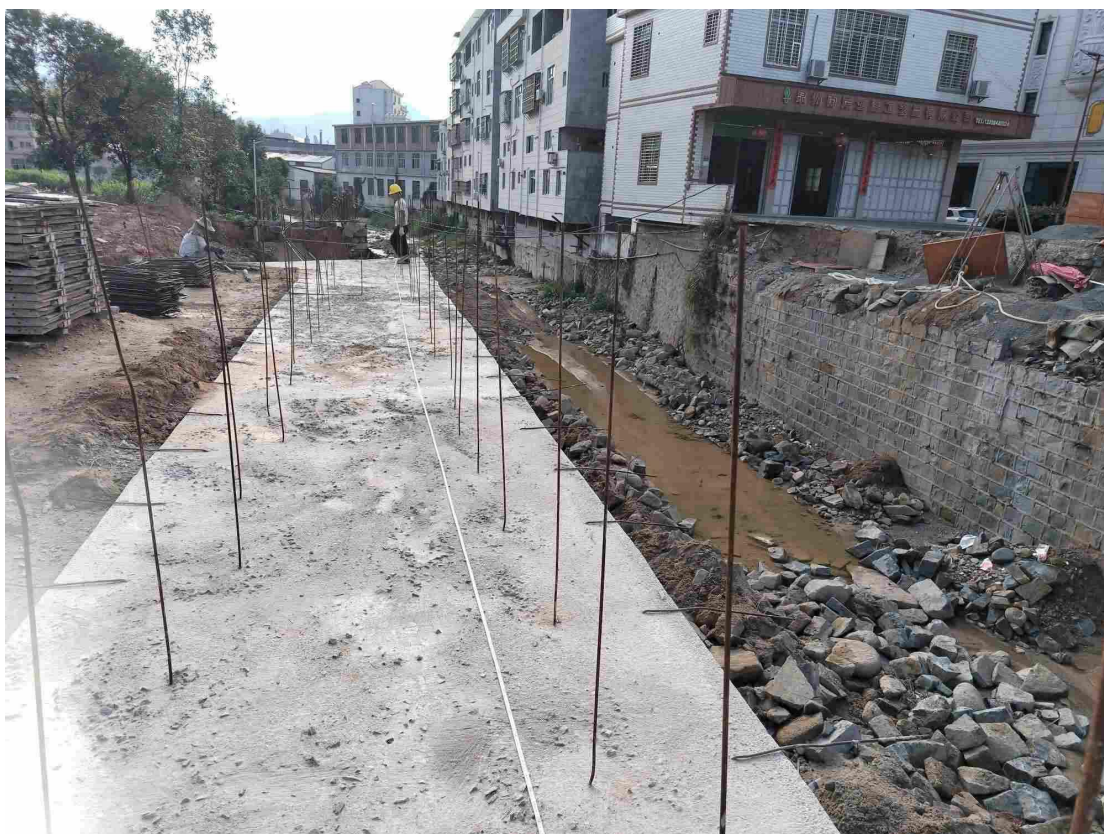
图 4 安溪县尚卿乡灶美村灶美小桥重建
