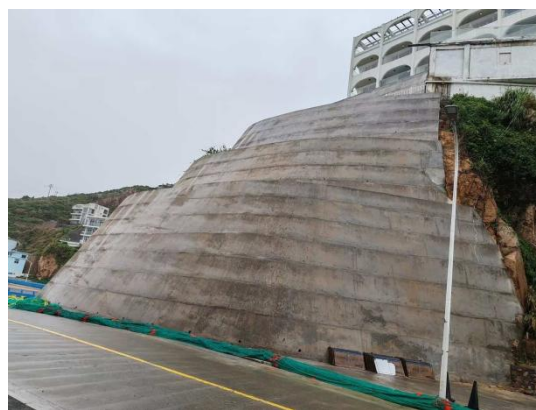
图 2 构嵯线 K2+220 修复后
