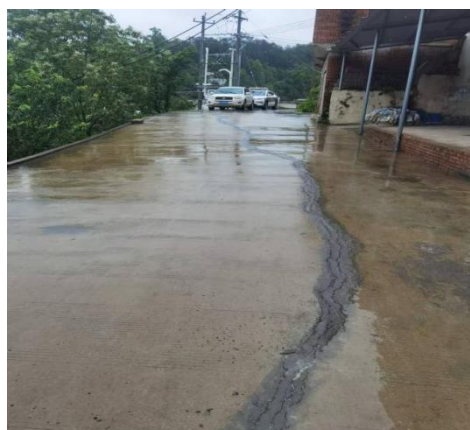
图 13 对不稳定山体增设上挡墙预防塌方风险 图 14 开展路面裂缝处置防范病害扩大
