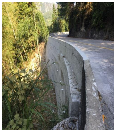
图 6 临石线 K109+200 (修复后)
