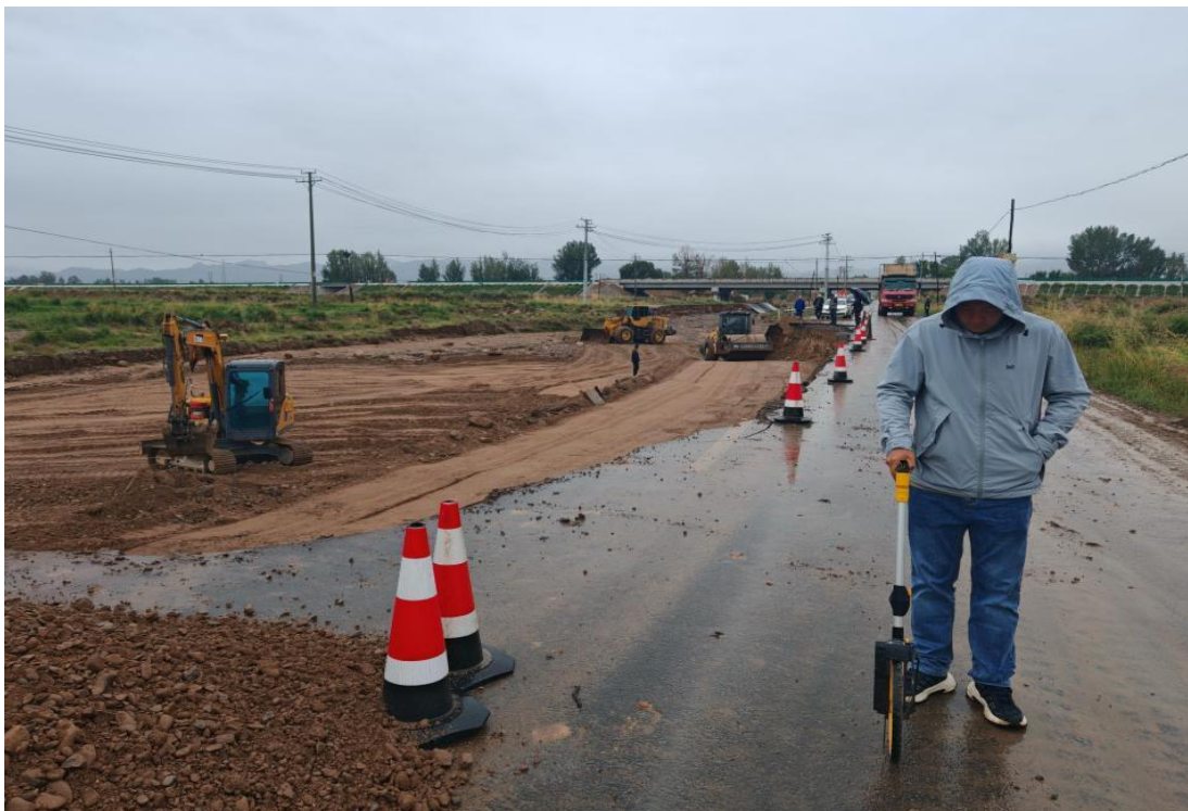
图1 永昌“8·25”暴雨洪涝灾害现场
