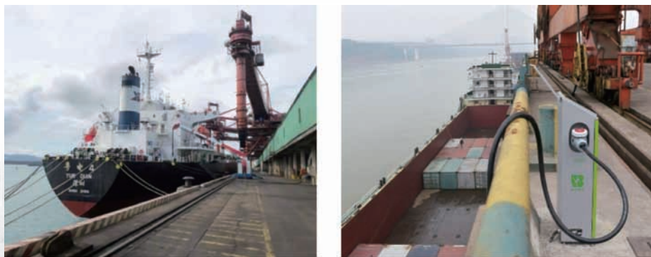
图 21 码头岸电系统
