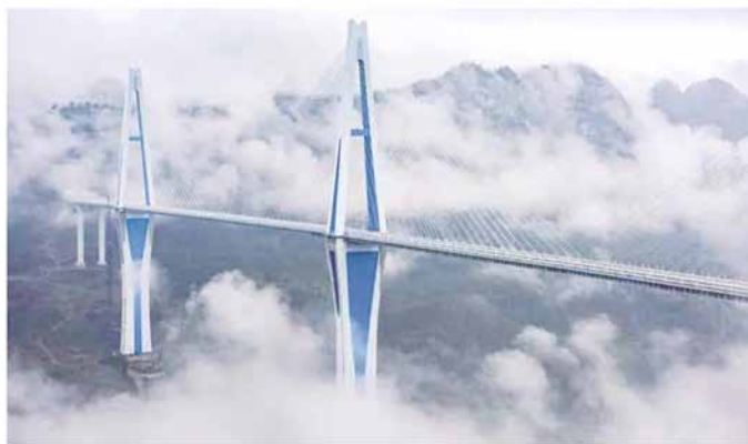
图8 贵州省平塘县平罗高速平塘特大桥
