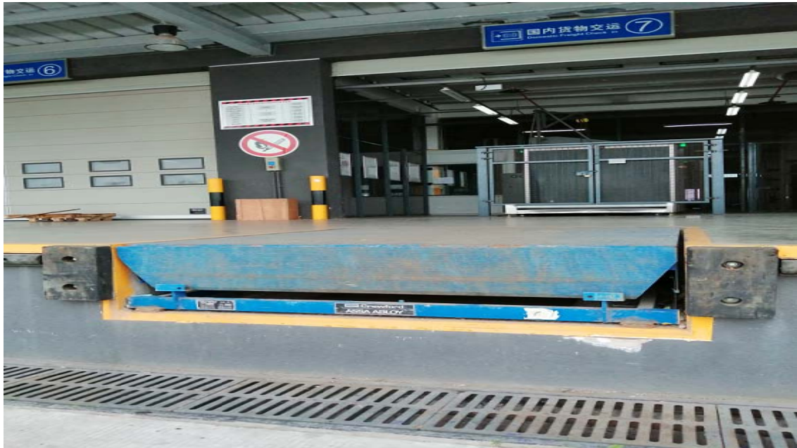
图 10 液压高度调节板
