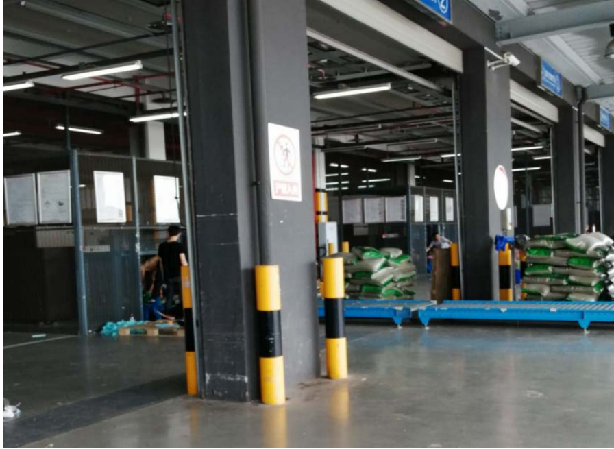
图 3 防撞设施表面喷涂的颜色
